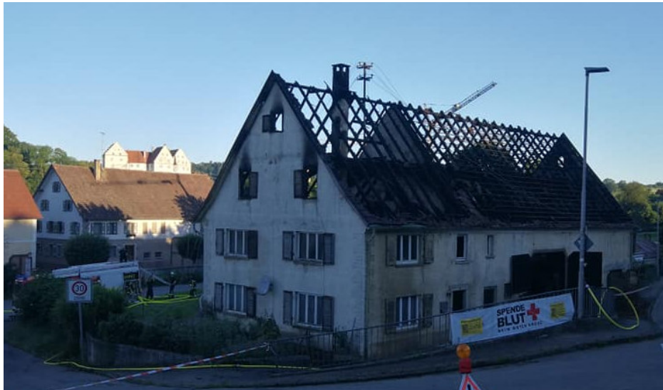
Bild: Ansicht aus Richtung Süd-Ost, von der Jakobstaler Straße aus
